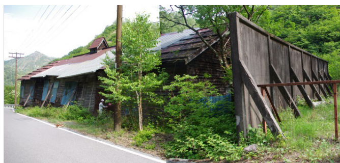
写真-1 本山動力所の北西側からの外観
