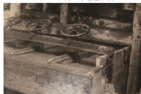
図-3 ミネラルセパレーション型浮遊選鉱機
