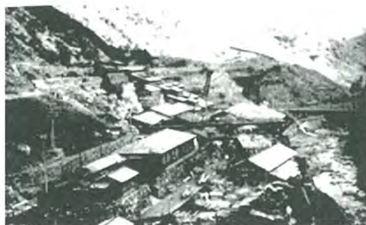
図-6 大正期の馬立地区(中央の建物が本部、その奥斜面に選鉱所、手前が坑木置き場)
