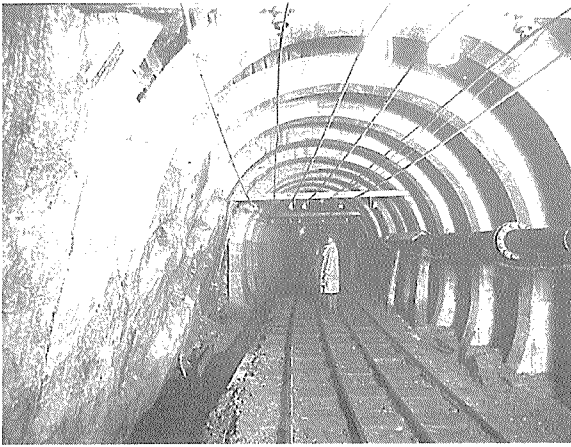
有木坑内部（古河機械金属㈱提供）
