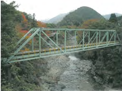
No. 8 渡良瀬水路橋
