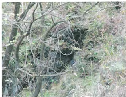
No. 4 発電所導水管跡地（深沢隧道）
