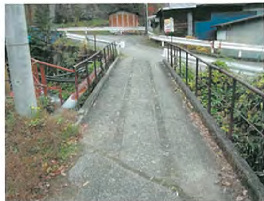
図-4 簡易軌道の跡が残る有越沢河口人道橋
