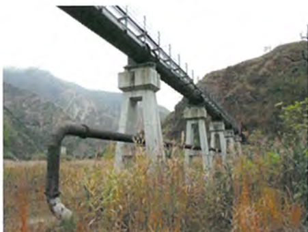
No. 2 古河用水仁田元水管橋
