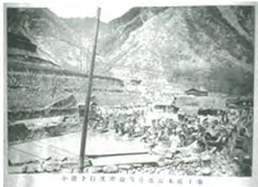
図-3 明治30年小滝浄水場の整備
