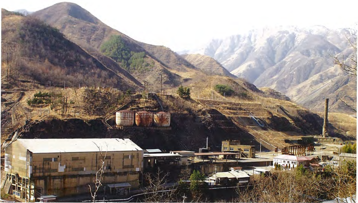
【製錬施設】本山製錬所全景
