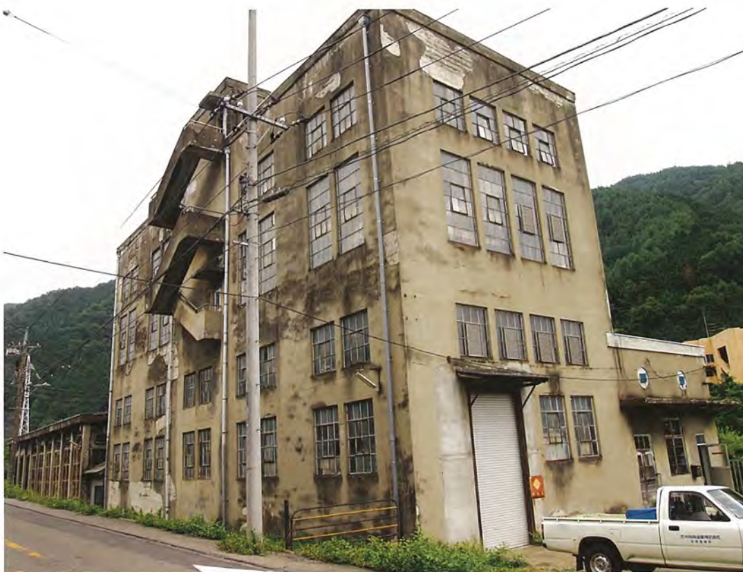
【エネルギー施設】通洞変電所
