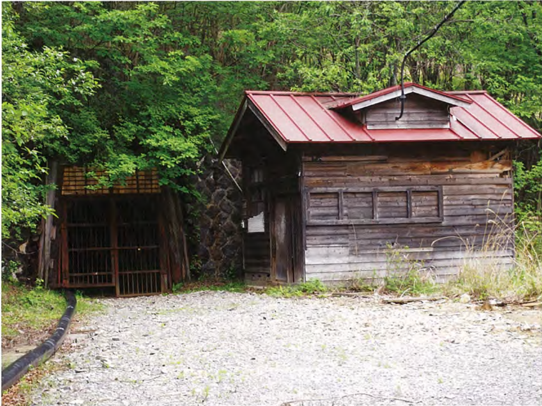
【採鉱施設】本山坑口
