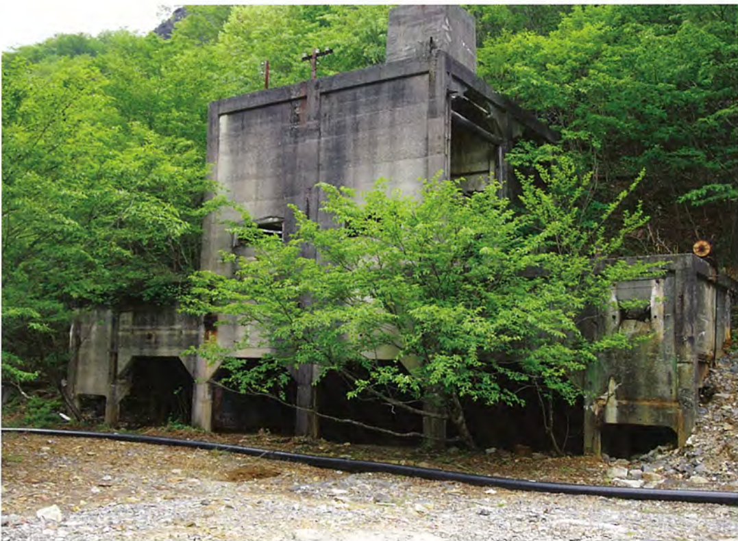
【採鉱施設】本山坑口前貯鉱関係施設
