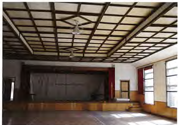
本山小学校講堂内部
