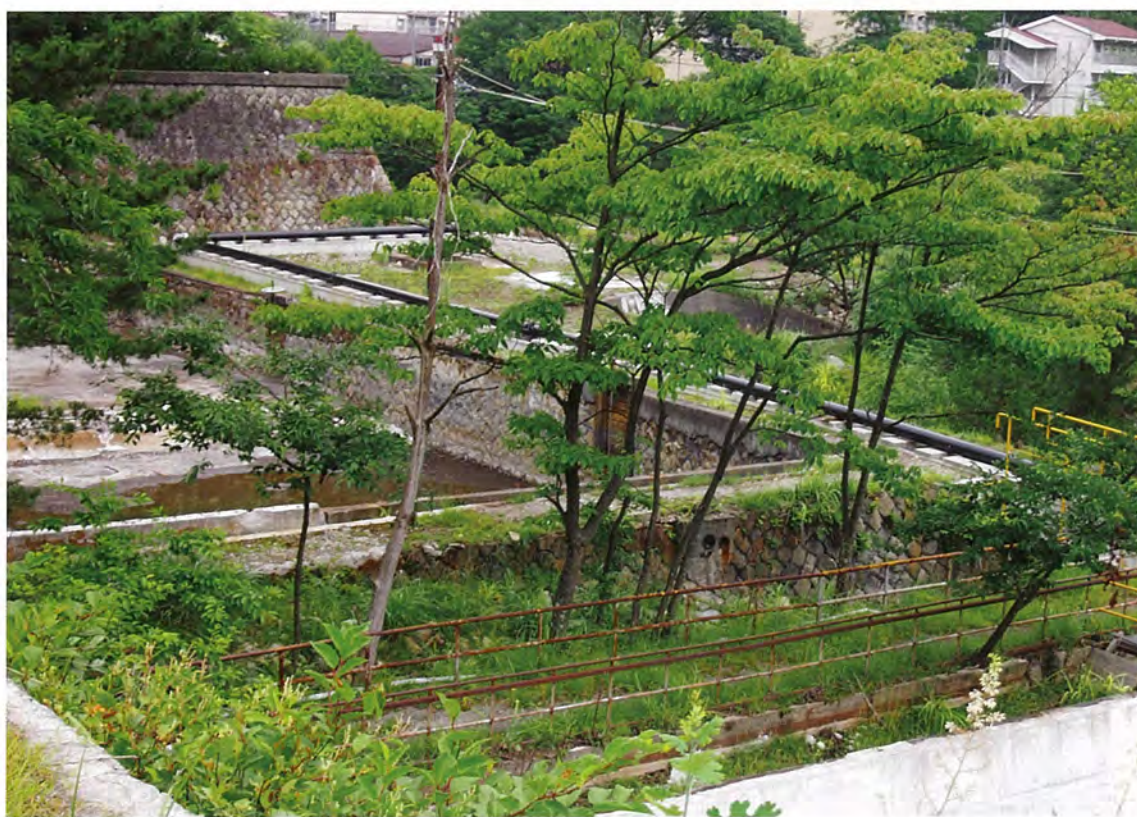
【浄水施設】間藤浄水場
