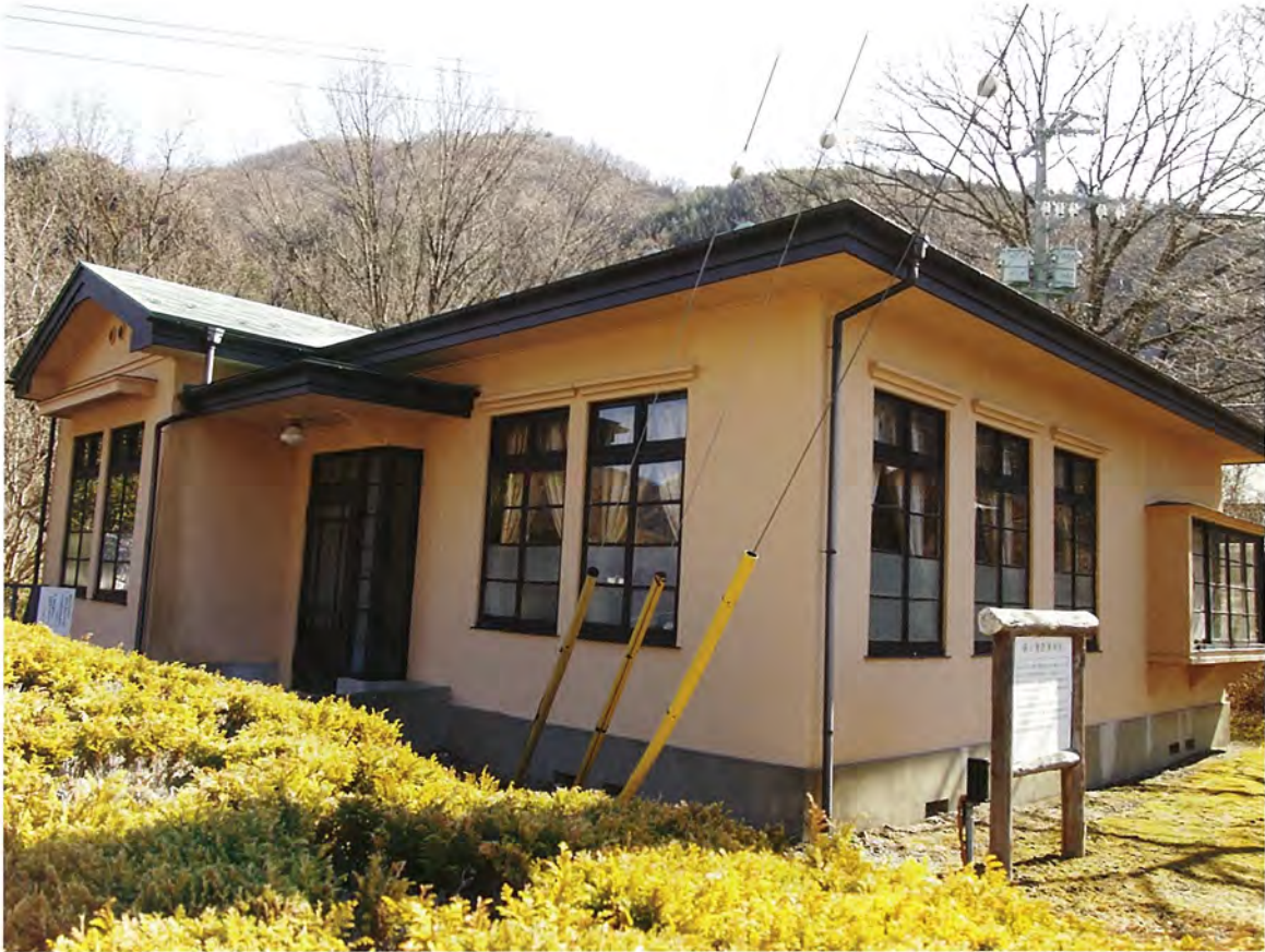
【輸送・通信施設】電話交換所
