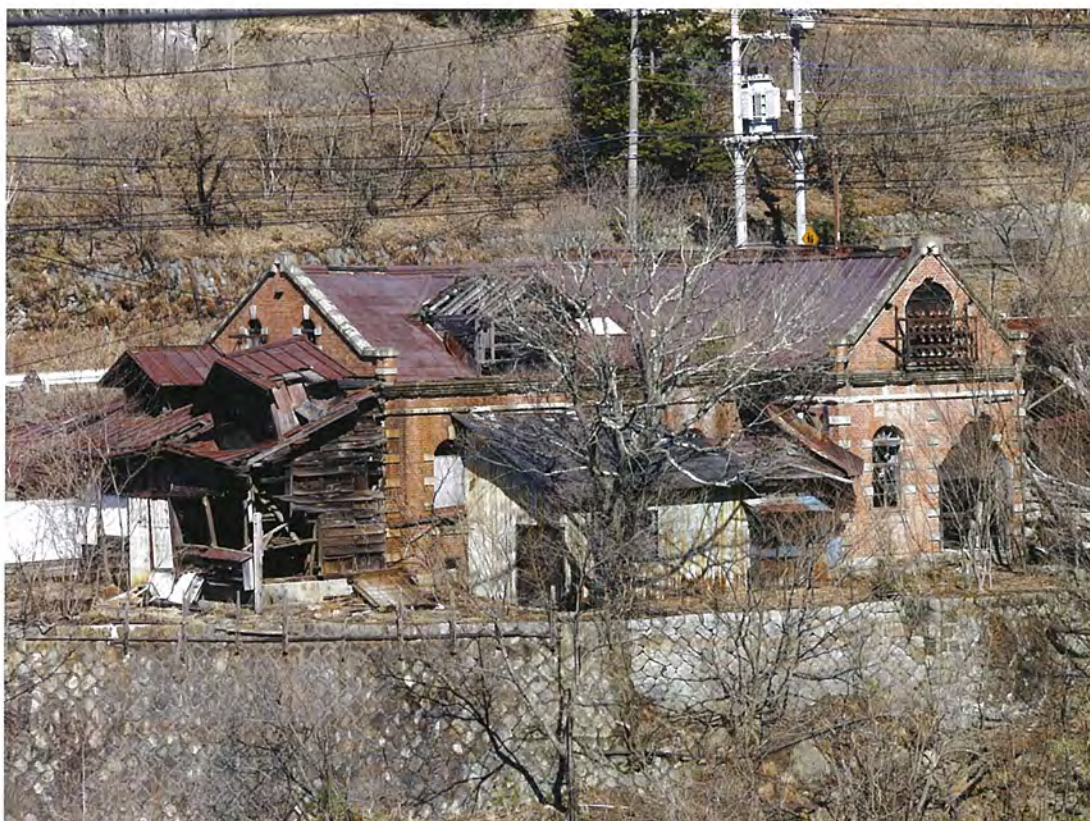
【採鉱施設】通洞動力所
