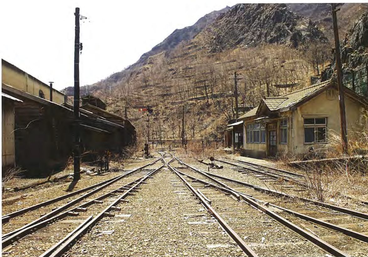
【輸送・通信施設】足尾鉄道本山駅
