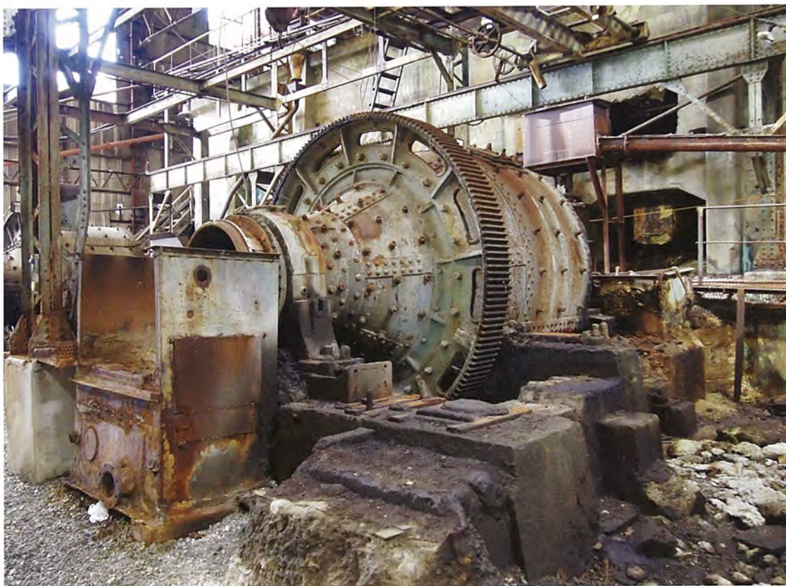
【選鉱施設】通洞選鉱所内ボールミル
