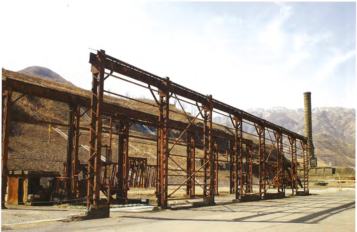
【製錬施設】本山製錬所クレーン支柱
