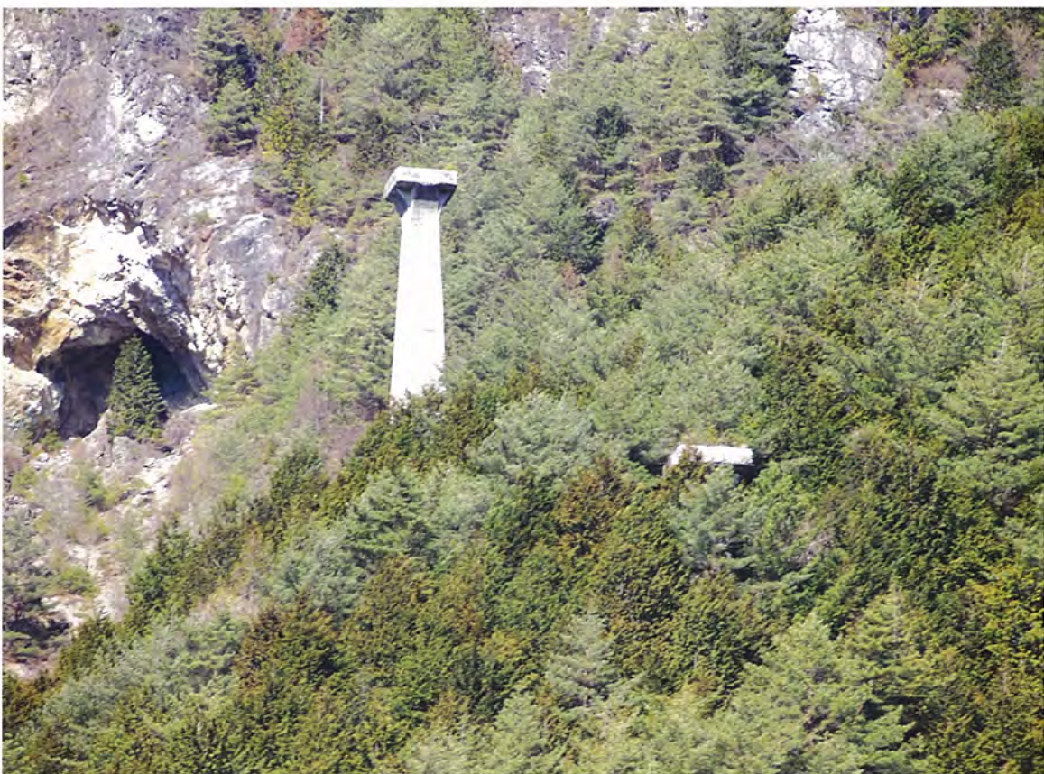
【輸送・通信施設】有越（第三）鉄索塔
