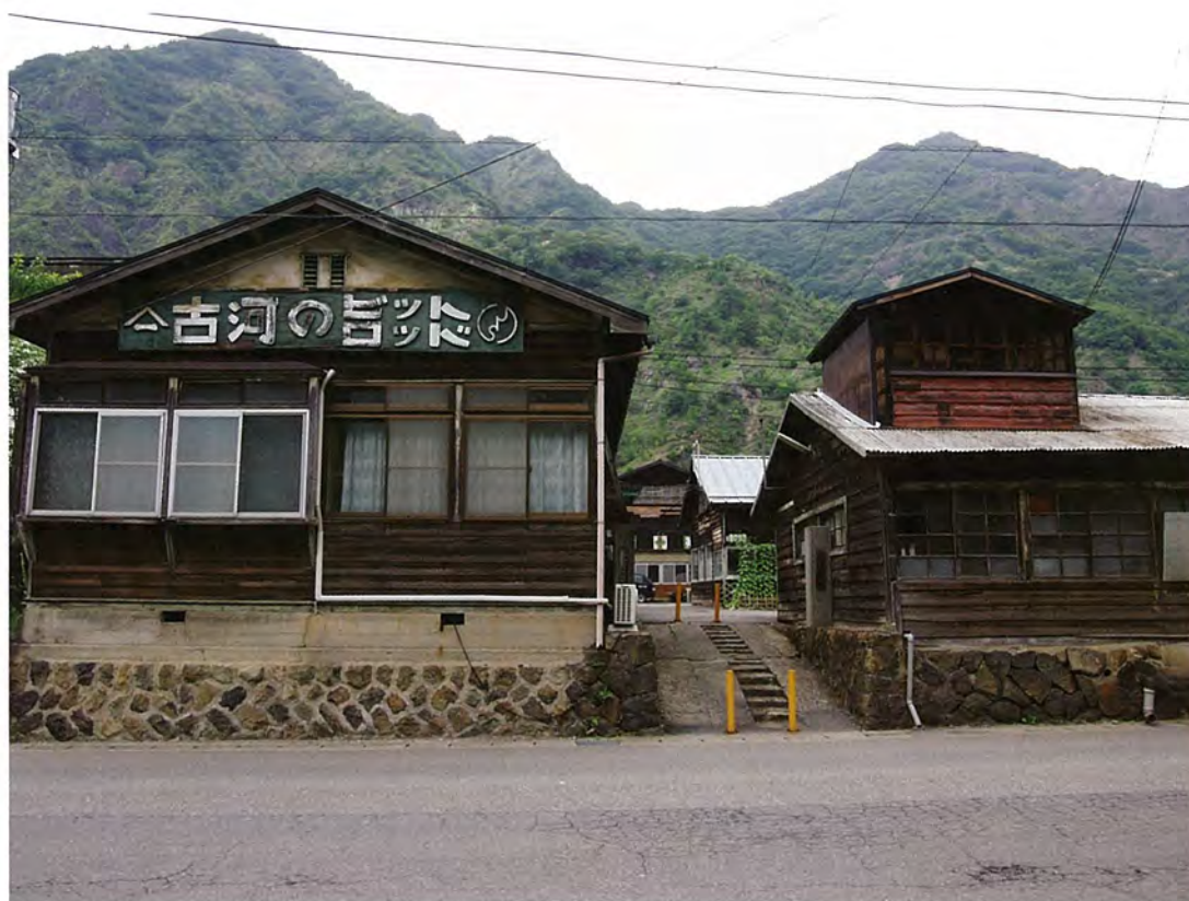
【維持管理に関する施設】古河鉱業間藤工場（現古河キャステック株式会社）
