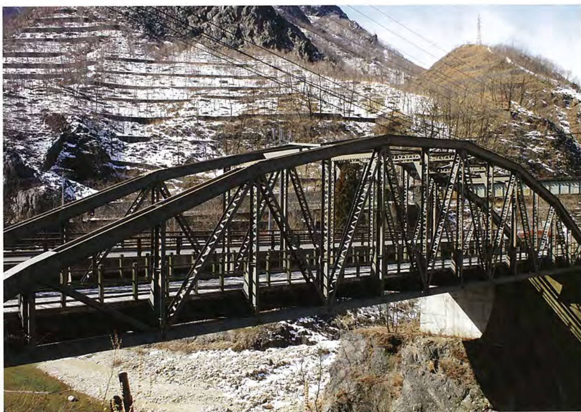
【輸送・通信施設】古河橋（市指定有形文化財）
