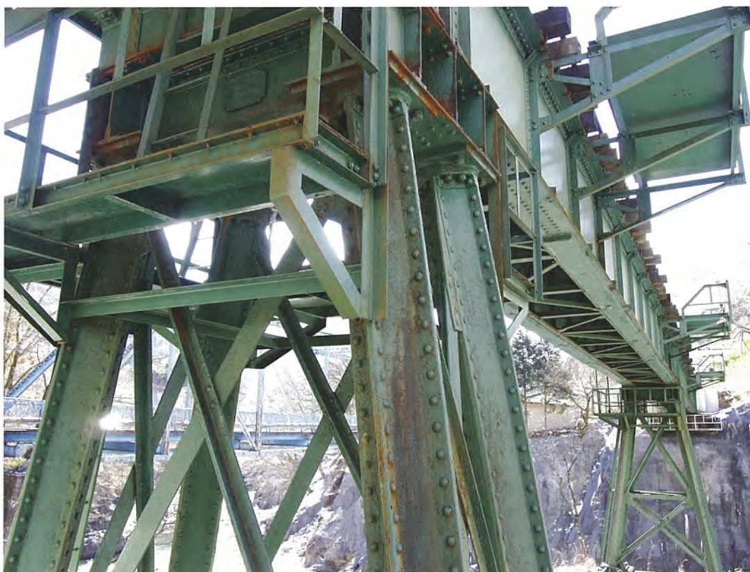
【輸送・通信施設】足尾鉄道第一松木川橋梁(国登録有形文化財)(現わたらせ渓谷鉄道)
