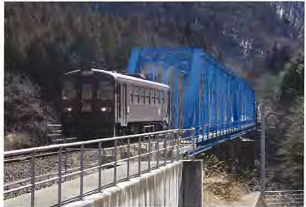
足尾鉄道第二渡良瀬川橋梁
