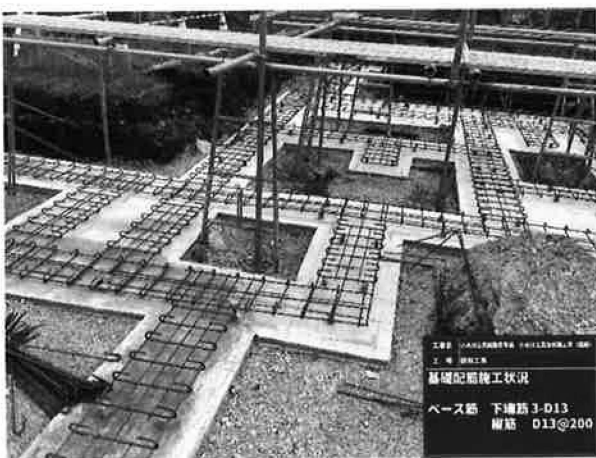
写真-3 基礎配筋施工状況
