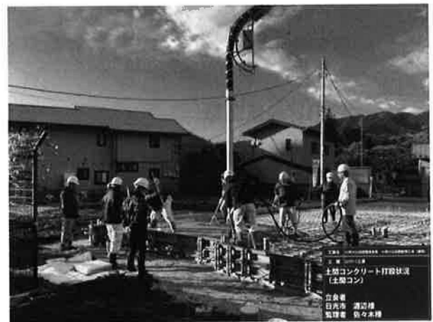
写真-4 土間コンクリート打設状況
