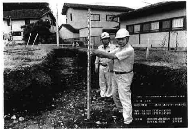
写真-2 床付け検査実施状況
