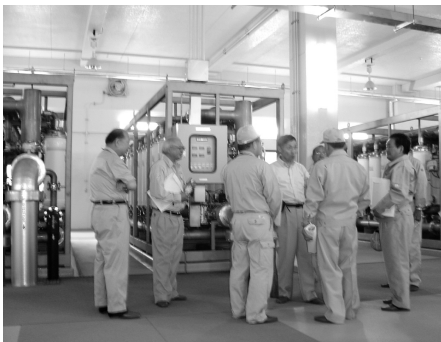
今市地域の美味しい水を供給しています (瀬尾浄水場)
