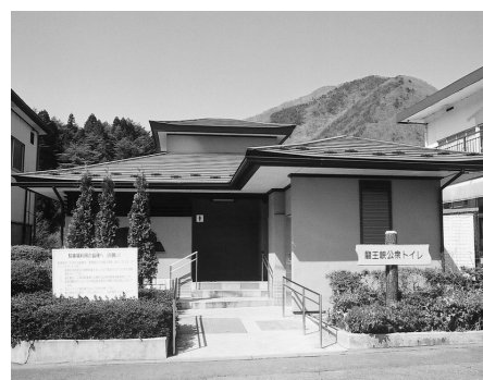
多くの市民や観光客が利用しています （龍王峡公衆トイレ）
