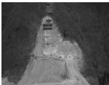
湯西川ダム建設現場
