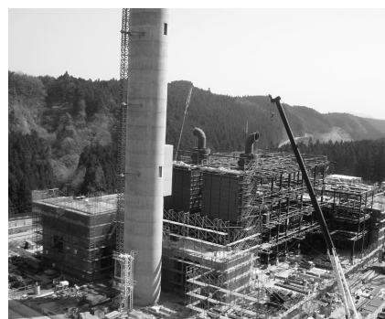
（仮）日光市クリーンセンター建設現場
