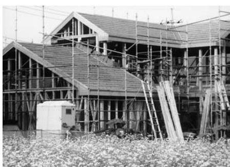
木材を使った建築中の住宅
