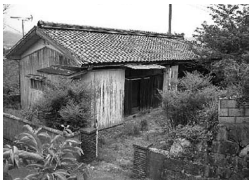
市内の空き家
