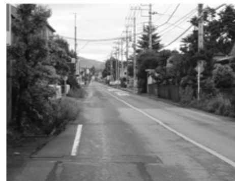
歩道のない通学路
