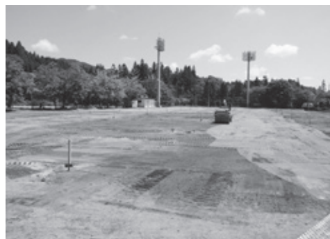
校庭の除染作業
