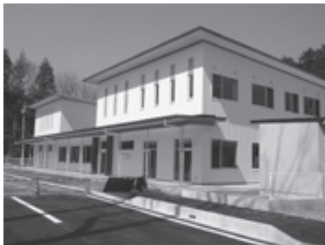
落合支所・公民館（平成26年3月完成）
