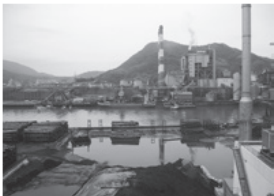
広島県呉市のバイオマス発電施設
