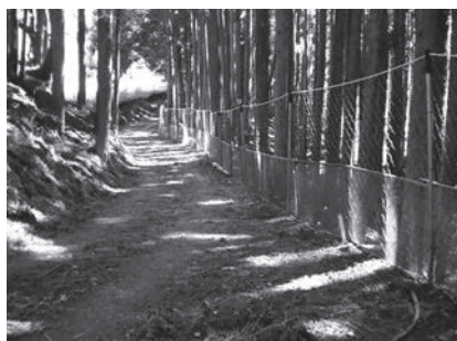
26年度に設置された藤原地域防護用ネット柵
