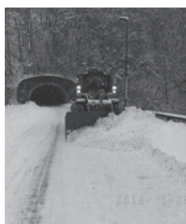
除雪作業の様子
