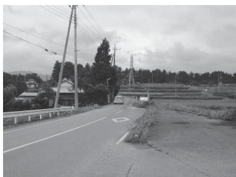
道路拡幅が望まれる「市道今2048号線」 (文挟～猪倉線)
