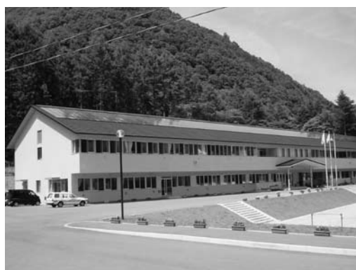
湯西川小中学校のソーラー発電
