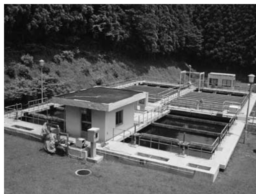
毎日おいしい水を供給している藤原浄水場
