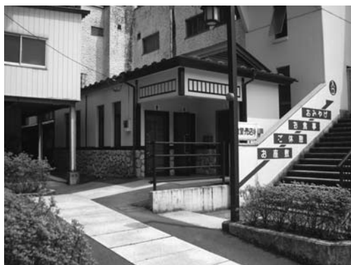
西参道公衆トイレ
