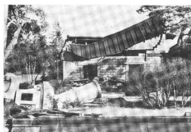
倒壊した石蔵
