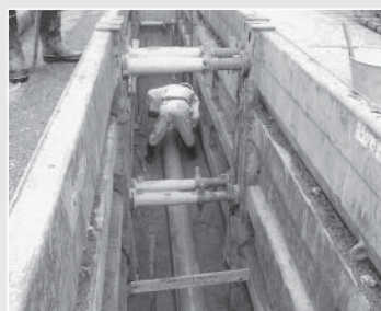
公共下水道建設事業費 下水管敷設工事の様子です。
