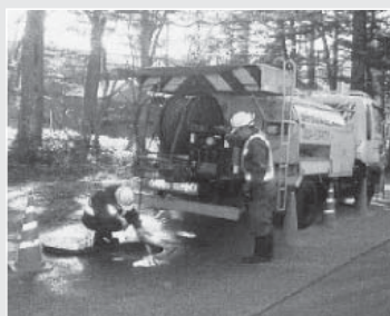
下水道維持管理費 湯元処理区の管渠清掃の様子です。
