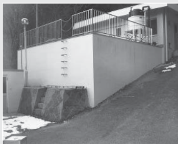
足尾南部浄水場改良事業費
