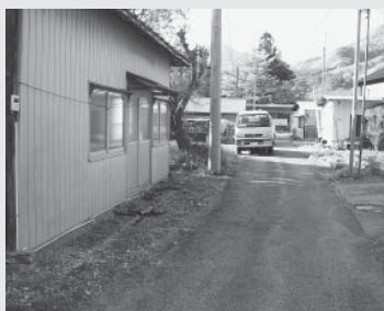
市単道路整備事業費 道路を拡げて安全な交通の確保を図ります。
