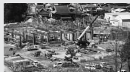
足尾小学校建設事業
