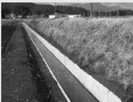
基盤整備促進事業 昨年度、今市地域の板橋地内に完成した農業用の用排水路です。
