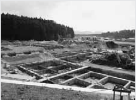
(仮)大沢地区センター整備事業 整備概要 敷地面積 18,719.77㎡ ○支所公民館棟(1,248.80㎡) 鉄筋コンクリート造、地上1階建 ○体育館棟(2,994.69㎡) 鉄筋コンクリート造 地上1階・地下1階建 ※昨年6月に造成工事、9月に建設工事を着工しています。
