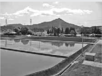
県営圃場整備事業 沓掛地区(今市地域)に整形されたほ場および整備された道路・水路です。
