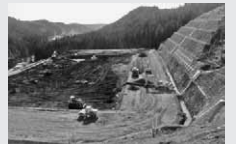
クリーンセンター建設 新しく建設されるクリーンセンターの工事の様子です。平成20年度には、建物の工事も始まります。
