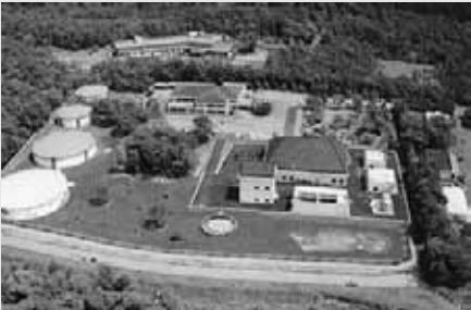
今市上水道拡張事業 最新の浄水方法である膜ろ過設備を有する瀬尾浄水場。
