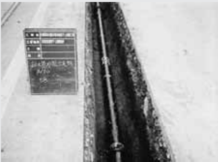
足尾北部簡易水道配水管布設替事業 足尾地域の間藤地区での老朽水道管布設工事の様子。石綿セメント管からダクティル鉄管に交換しています。
