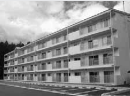
倉ヶ崎住宅建設事業 昨年度完成した 1 号棟住宅です。
