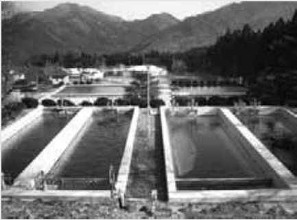
日光上水道施設整備事業 日光上水道給水区域に安全な飲料水を供給するために、安良沢浄水場の改修工事を行います。
