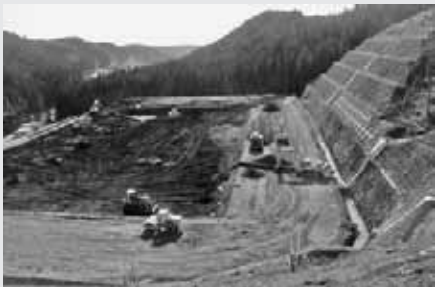
クリーンセンター建設 新しく建設されるクリーンセンターの工事の様子です。平成20年度には、建物の工事も始まります。
