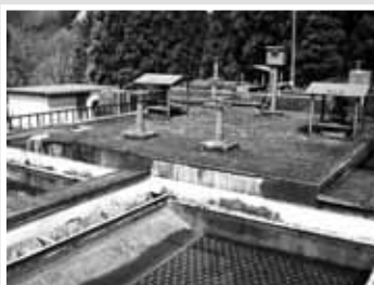
藤原地域小網浄水場改修事業費 藤原地域小網浄水場の現在の様子です。
