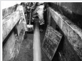
公共下水道建設事業費 污水排水管の布設工事を行います。写真は平成町(今市地域)の布設工事の様子です。
