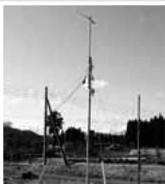
地上デジタル放送難視対策事業費 昨年度整備された共同受信施設の受信アンテナです。これにより、地上デジタル放送を良好に視聴することができます。
