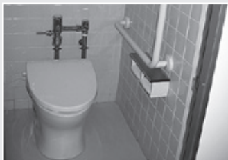
小学校校舎等維持管理費 平成26年度にトイレの洋式化及び床の乾式化を行った今市小学校の様子です。
