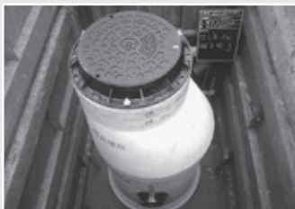
公共下水道建設事業費 板橋地内（今市地域）のマンホール設置の様子です。
