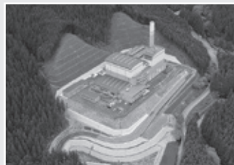
クリーンセンター維持管理費 燃えるごみは、炉内で溶融してスラグ（無害なガラス質の粒）化し、道路用材料などにリサイクルします。また、燃やした時の熱は、施設内の発電に利用しています。
