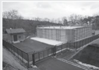
日光地域配水管布設替等事業 昨年度に完成した小倉山配 水池の様子です。
