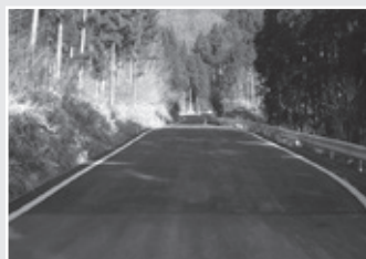
県単林道改良事業費 林道の改良工事で、舗装新設した林道小沢入線です。
