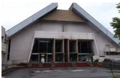
日光総合会館(昭和47年築)
