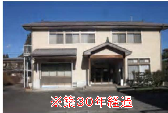
小来川林業研修センター(平成3年築)
