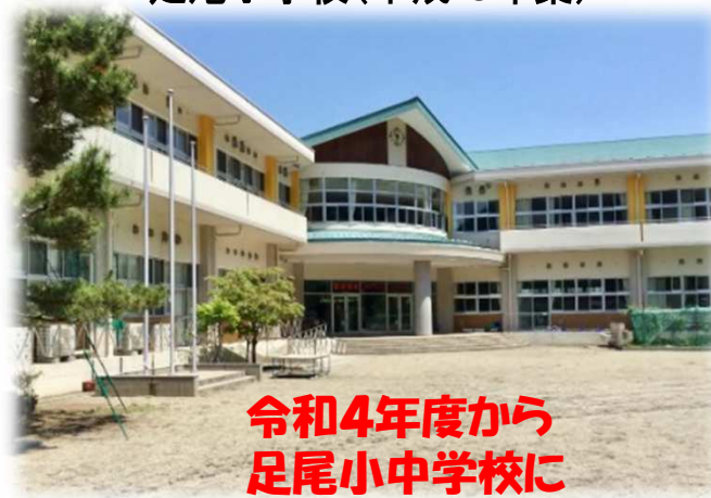
足尾小学校(平成19年築)
